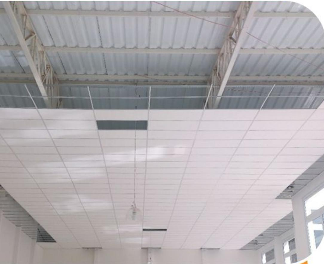
*O forro de EPS pode ser aplicado em todos os tipos de obra, unindo estética, isolamento térmico, conforto acústico e boa iluminação para os ambientes.*
